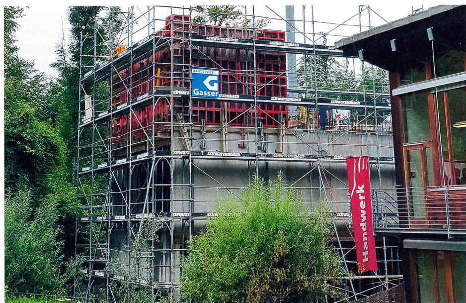
Schalung des dritten Stockes beim neuen Kursgebäude auf dem Werkhofareal Ballenberg
