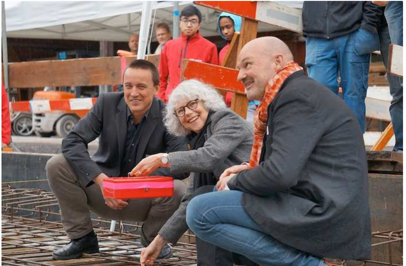
Architekt Yorick Ringeisen, Initiantin Ursula Trunz und der Leiter des Kurszentrums Ballenberg Adrian Knüsel (vlnr) versenken eine Zeitkapsel als Grundstein für den Erweiterungsbau. Fotos: Nora Devenish
